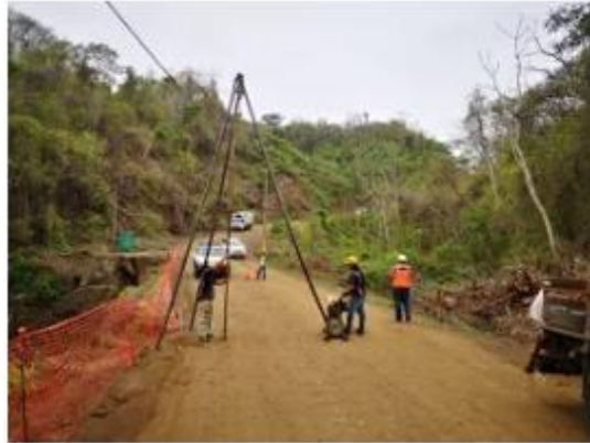
Figura 4. Servicios Ingeniería Gamboa S.A
