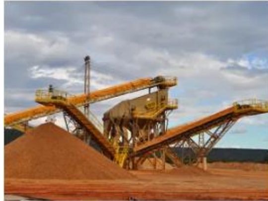
Figura 13. Servicios Ingeniería Gamboa S.A.
