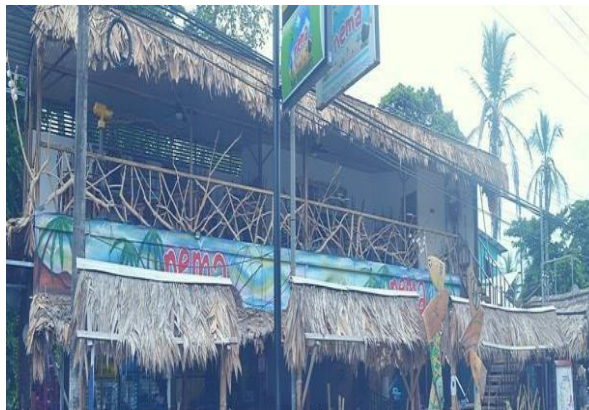
Ilustración 10. Fachada frontal del Restaurante Nemas
